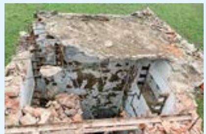
*Freie Sicht für die Anwohner: Stück für Stück wurde der Trafoturm in Borgloh dem Erdboden gleichgemacht. Steine und Baustoffe wurden selbstverständlich sortiert und fachgerecht entsorgt.*
